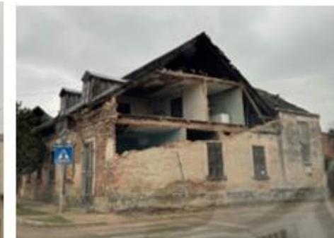
Slika 2 Gubitak cjelovitosti konstrukcije i odvajanje zidova od stropova zbog nedovoljne povezanosti
