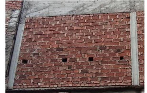
Slika 8 Primjer seizmički neprimjerenih zidanih zidova s blok opekom s horizontalnim šupljinama i šupljeg zidanoq zida od pune opeke
