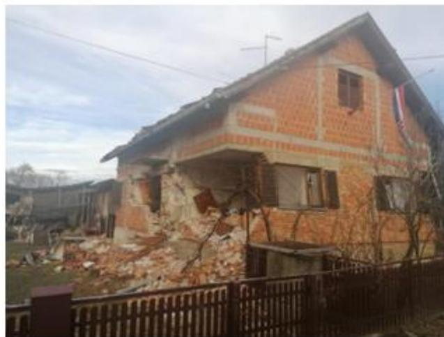
Slika 3 Fotografije oštećenja zgrada od nearmiranoa žiđa s betonskim stropovima
